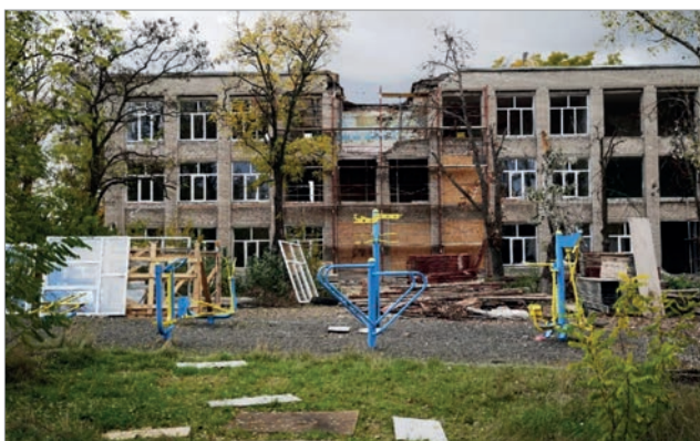
Рис. 2. Разрушенная школа в г. Мариуполе
