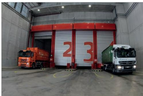
Рис. 5. Мусоросжигательный завод в Люцерне, Швейцария. Бункерное отделение закрытого типа
