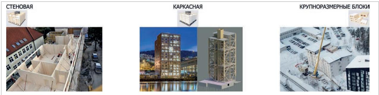
Рис. 1. Примеры различных конструктивных систем: стенная – Bridport House, арх. бюро Karakusevic Carson Architects, 2011, Лондон, Англия (слева); каркасная – Treet, арх. бюро Artes, 2011, Берген, Норвегия (в центре); крупноразмерные блоки – Риикюкка, арх. бюро ООРЕАА, 2014, Ювяскюля, Финляндия (справа)
