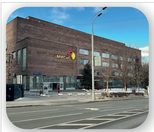
Рис. 1. Облицовка плитами из вулканического туфа здания корпуса «К» Университета науки и технологий МИСиС. Масштабная реконструкция по проекту В. Ф. Кринского, А. М. Рухлядева, 1932 г.
