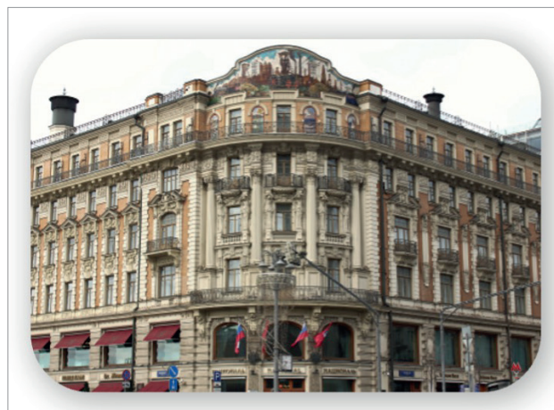
Рис. 2. Облицовка бежевым известковым туфом фасада здания отеля «Националь». Арх. А. Иванов, 1902 г.
