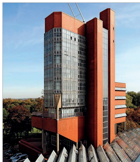
Рис. 1. Инженерный факультет Лестерского университета. Лестер, 1964
